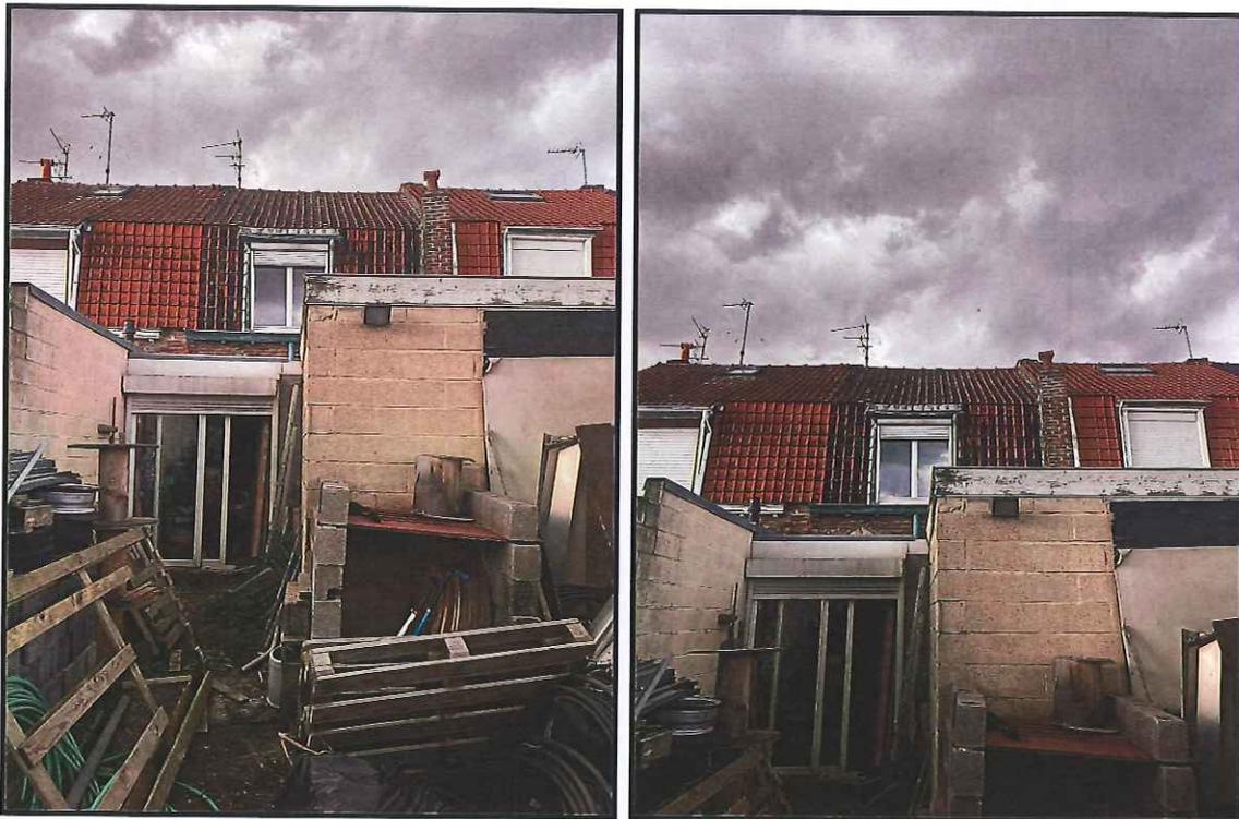
A noter qu'au niveau de la toiture, l'ensemble est en mauvais état, notamment au niveau de la partie chéneau, solins, zinc du châssis de fenêtre au premier étage.
