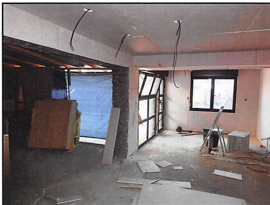
Présence d'une série de vitrages fixes, une porte-fenêtre et une double fenêtre, le tout en double vitrage à l'état neuf.
