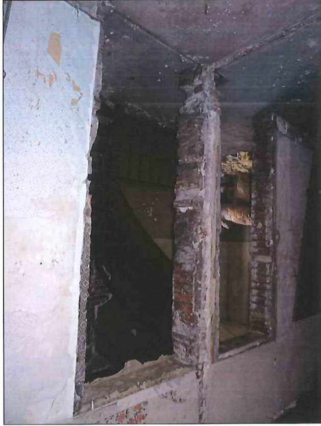
Du local n°6, j'accède au palier qui dessert l'entrée 2 et le second étage.
